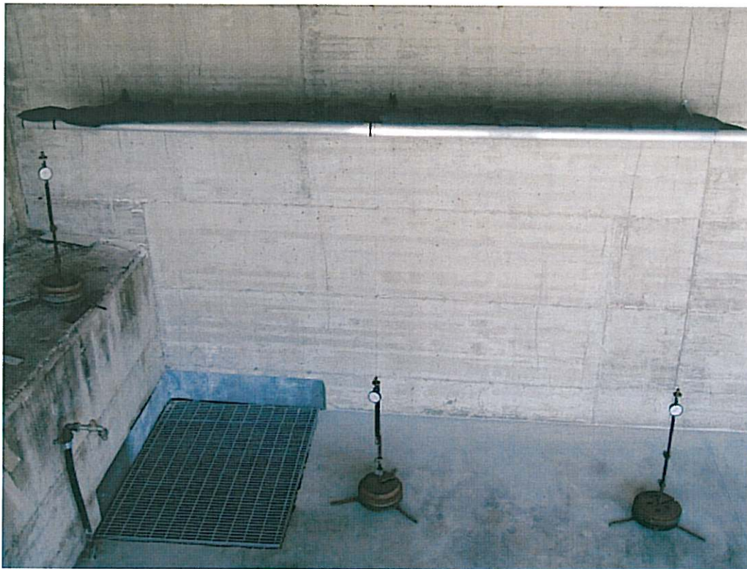
Fase 2 – Mensole all'estradosso
