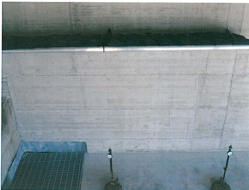
Fase 2 – Mensole all'estradosso
